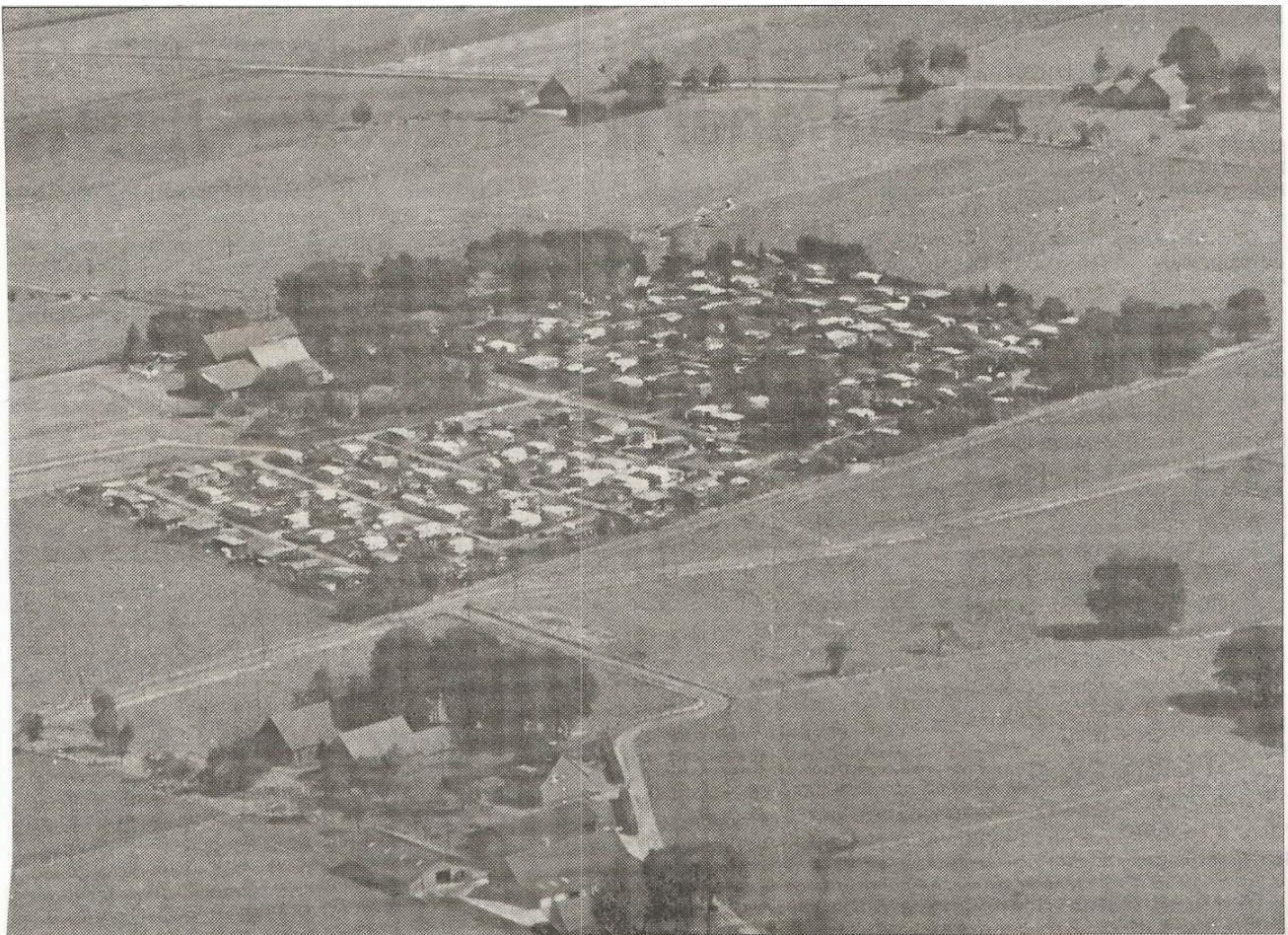
Der im vergangenen Jahr nochmals erweiterte Campingplatz Wachtenbrink im Ortsteil Damm gehört zu den zwölf Campingplätzen innerhalb der Gemeinde Schermbeck. RN-Luftbild: Scheffler
